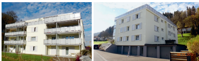
Sanierte Liegenschaft an der Gartenstrasse 2 in Neuenhof
